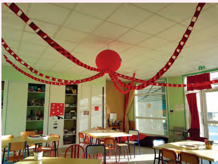
Le plafond rénové.
